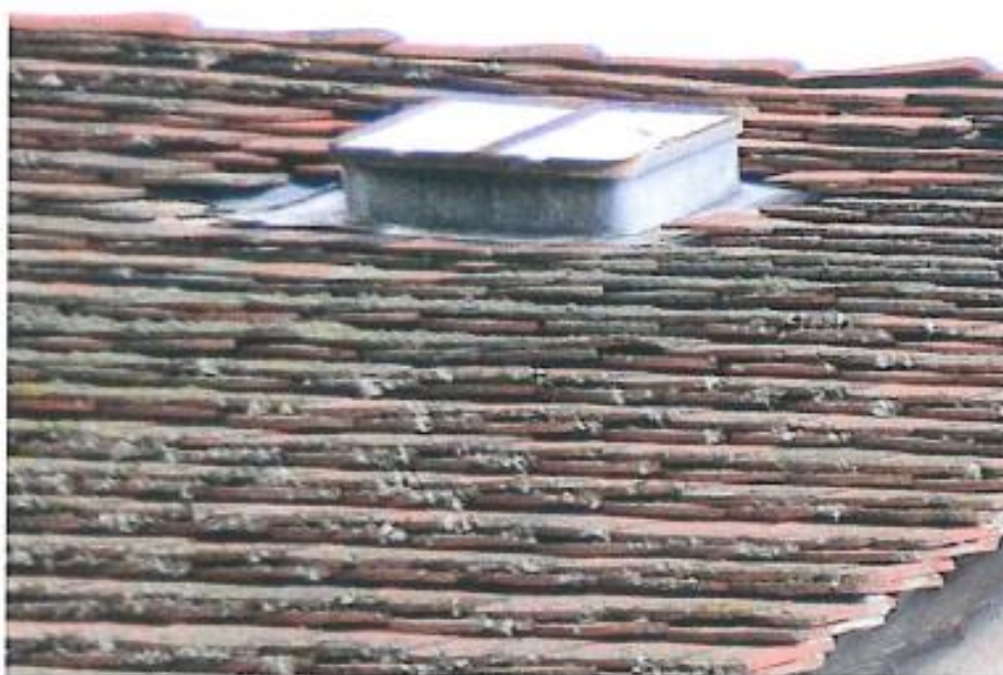
Fot. 10 Okienko wyłazowe na dach.
