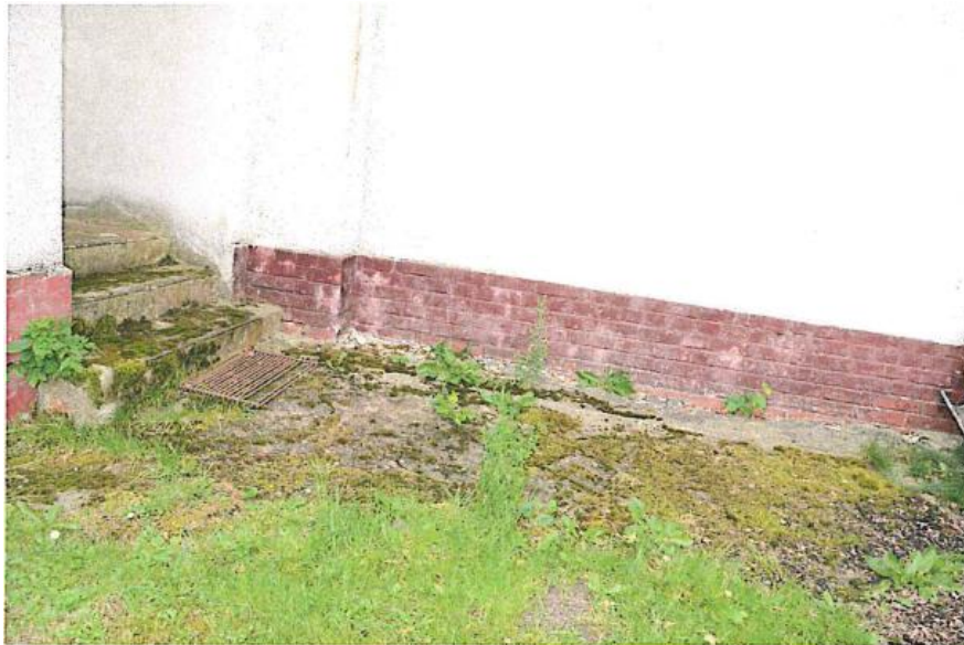
Fot. 13 Opaska betonowa.
