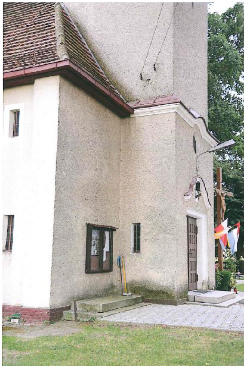
Fot. 14 Wejście do budynku. Elewacja północno-zachodnia.
