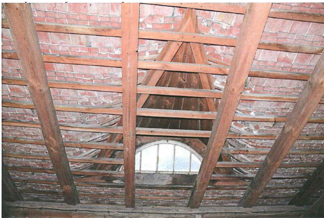
Fot. 15 Więżba dachowa.
