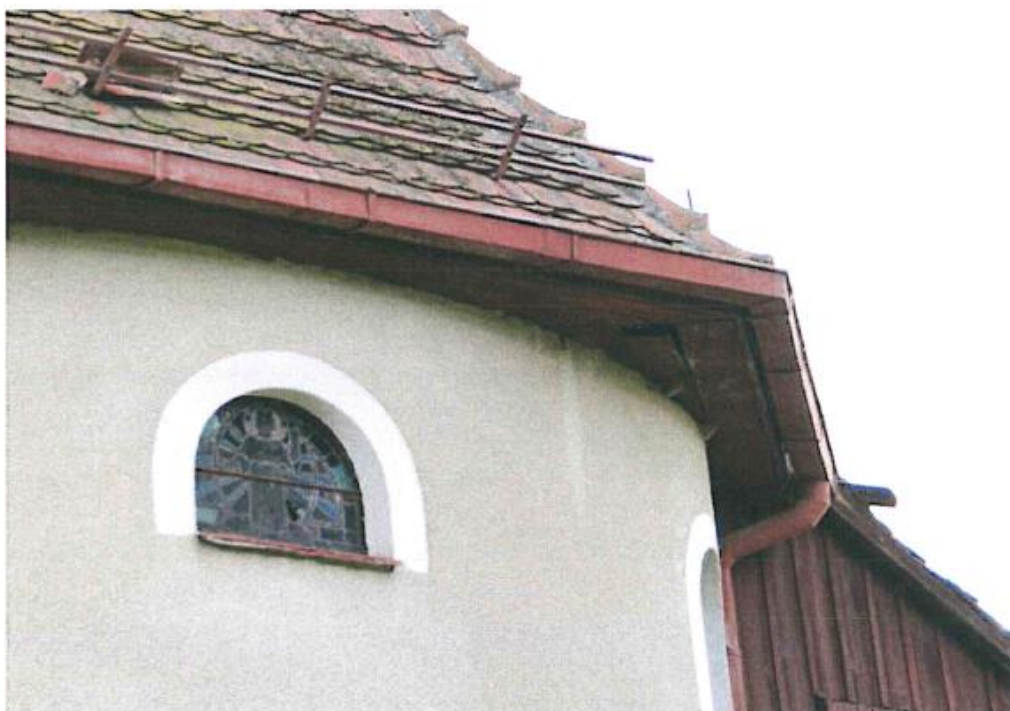
Fot. 11 Elewacja wschodnia. Widok fragmentu oszalowania ścian szczytowych.
