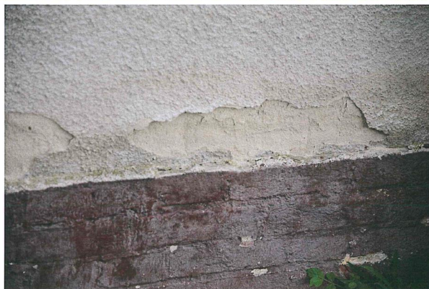
Fot. 5 Tynk w strefie przy cokołowej.
