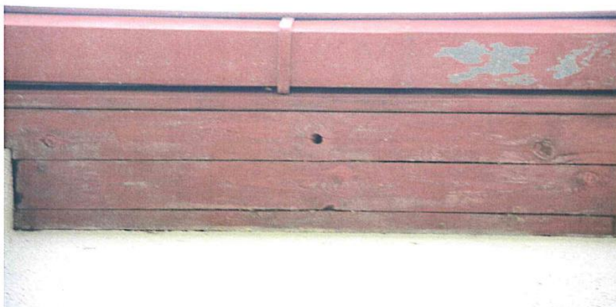
Fot. 6 Podbitka pod okapem dachu.
