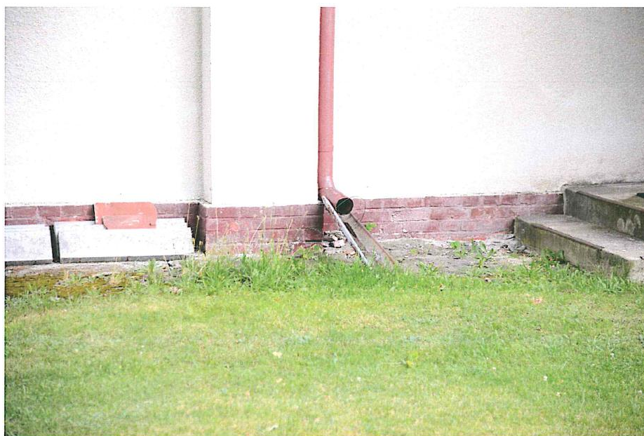
Fot. 8 Rura spustowa (elewacja południowa)
