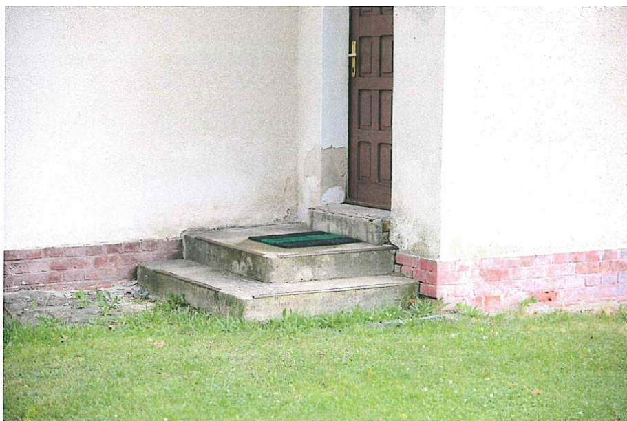
Fot. 9 Schody betonowe przed wejściem bocznym (elewacja południowa)
