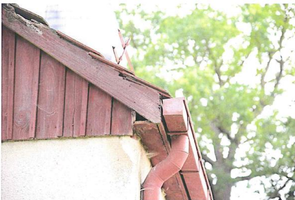
Fot. 12 Oszalowanie ściany szczytowej. Wiatrownica. Deska okapowa.
