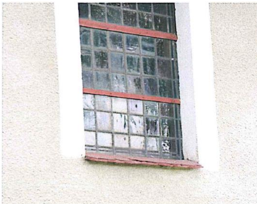
Fot. 3 Parapety zewnętrzne z dachówki ceramicznej.
