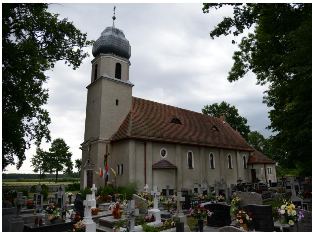
Fot. 20 Widok budynku od strony południowej.
