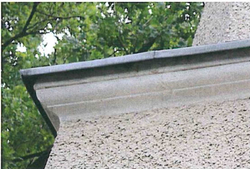
Fot. 1 Gzyms na wieży.
