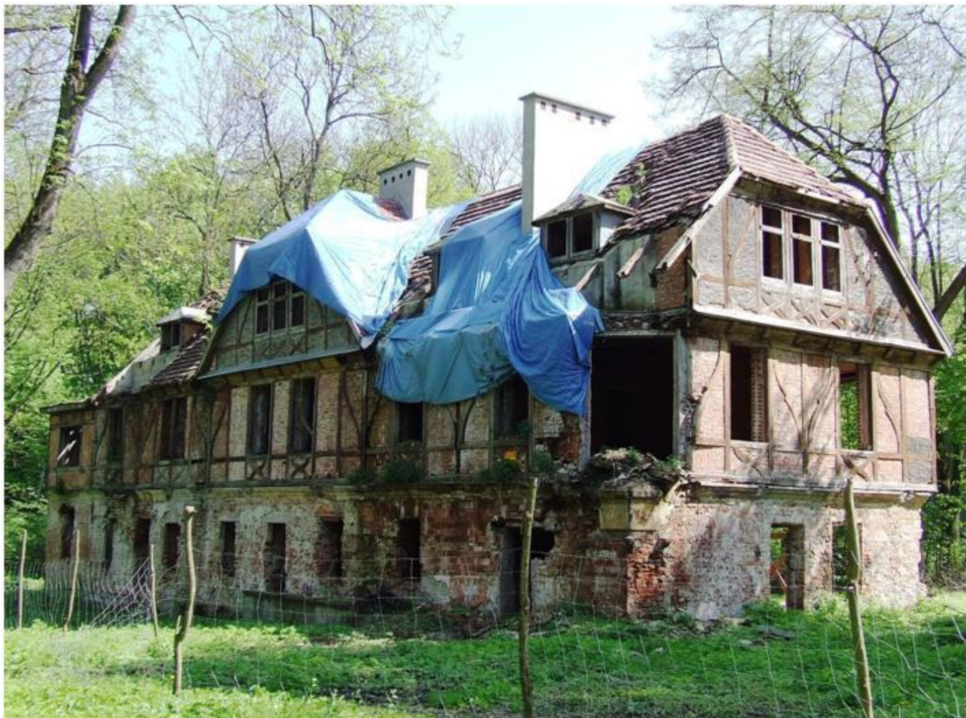
Widok na oficynę od strony południowo-zachodniej
