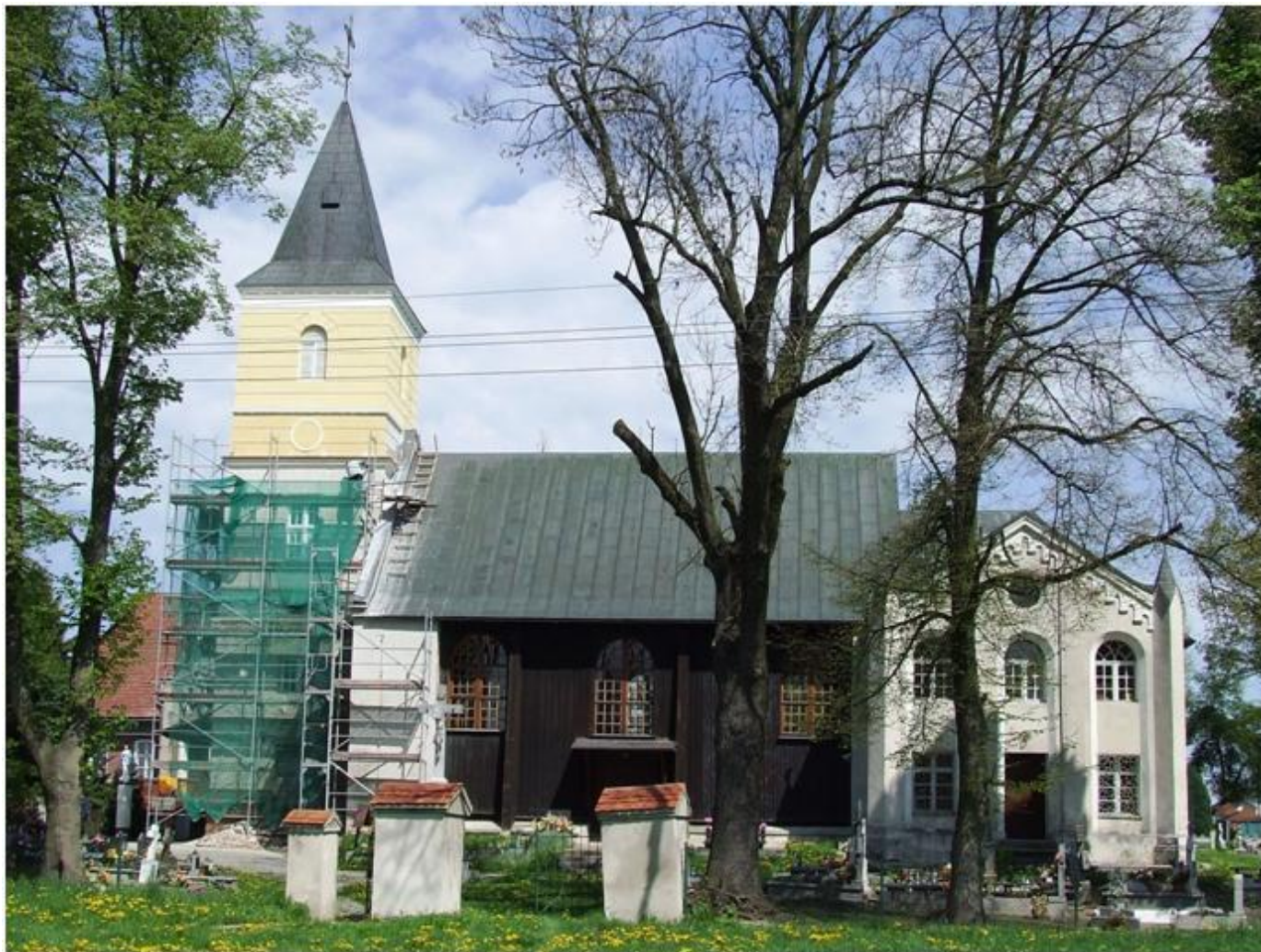
Widok na kościół od strony południowej
